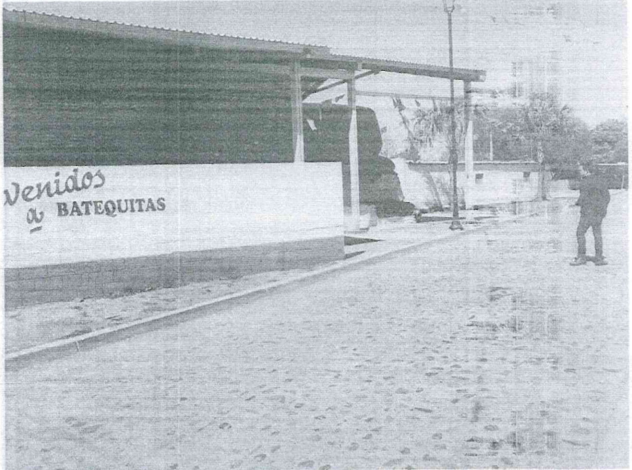
COMENTANDO LOS DETALLES DE BANQUETAS Y GUARNICIONES
