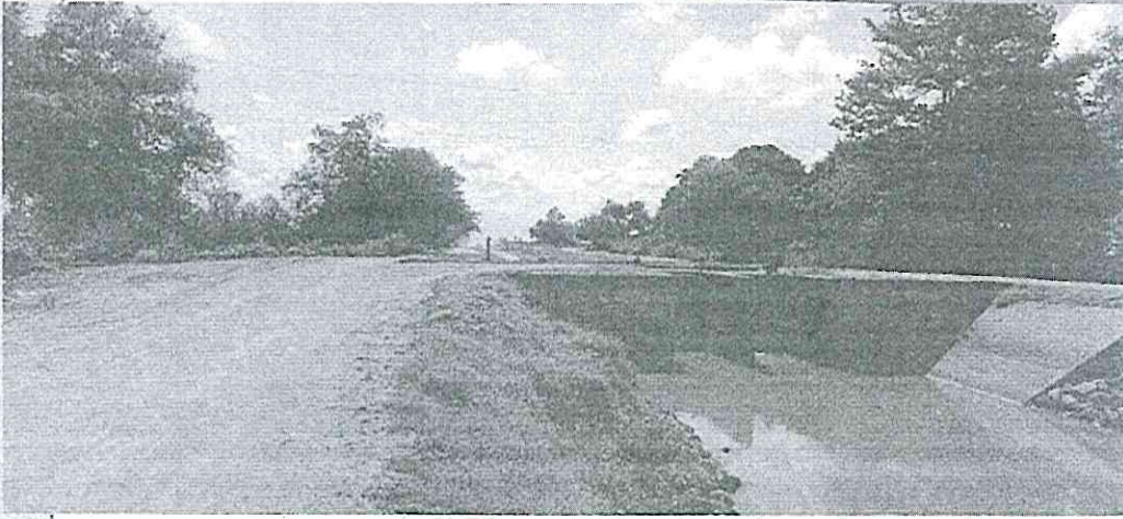
ASPECTOS DEL CAMINO ACTUAL
