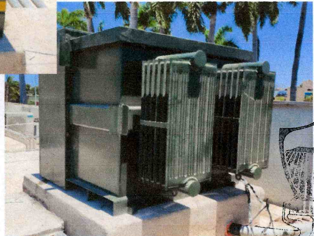
TRANSFORMADOR 300 KVA, TRIFASICO TIPO PEDESTAL
