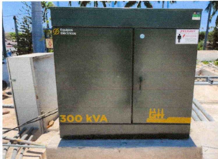
TRANSFORMADOR 300 KVA, TRIFASICO TIPO PEDESTAL
