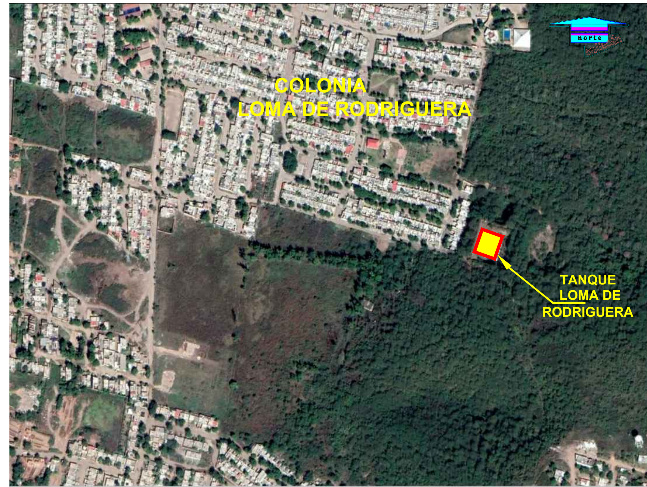
TANQUE LOMA DE RODRIGUERA
