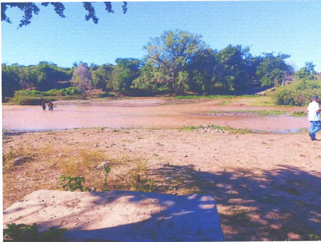
Fotografía visita a obra
