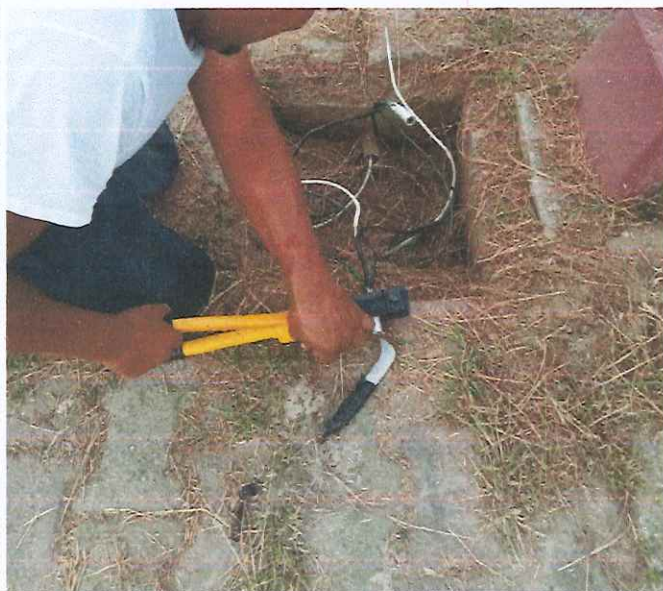
SUMINISTRO E INSTALACION DE CONECTOR TOPE PONCHABLE 1/0, INLCUYE: MATERIAL, MANO DE OBRA,
