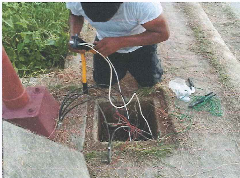
SUMINISTRO E INSTALACION DE CONECTOR TOPE PONCHABLE 1/0, INLCUYE: MATERIAL, MANO DE OBRA,
