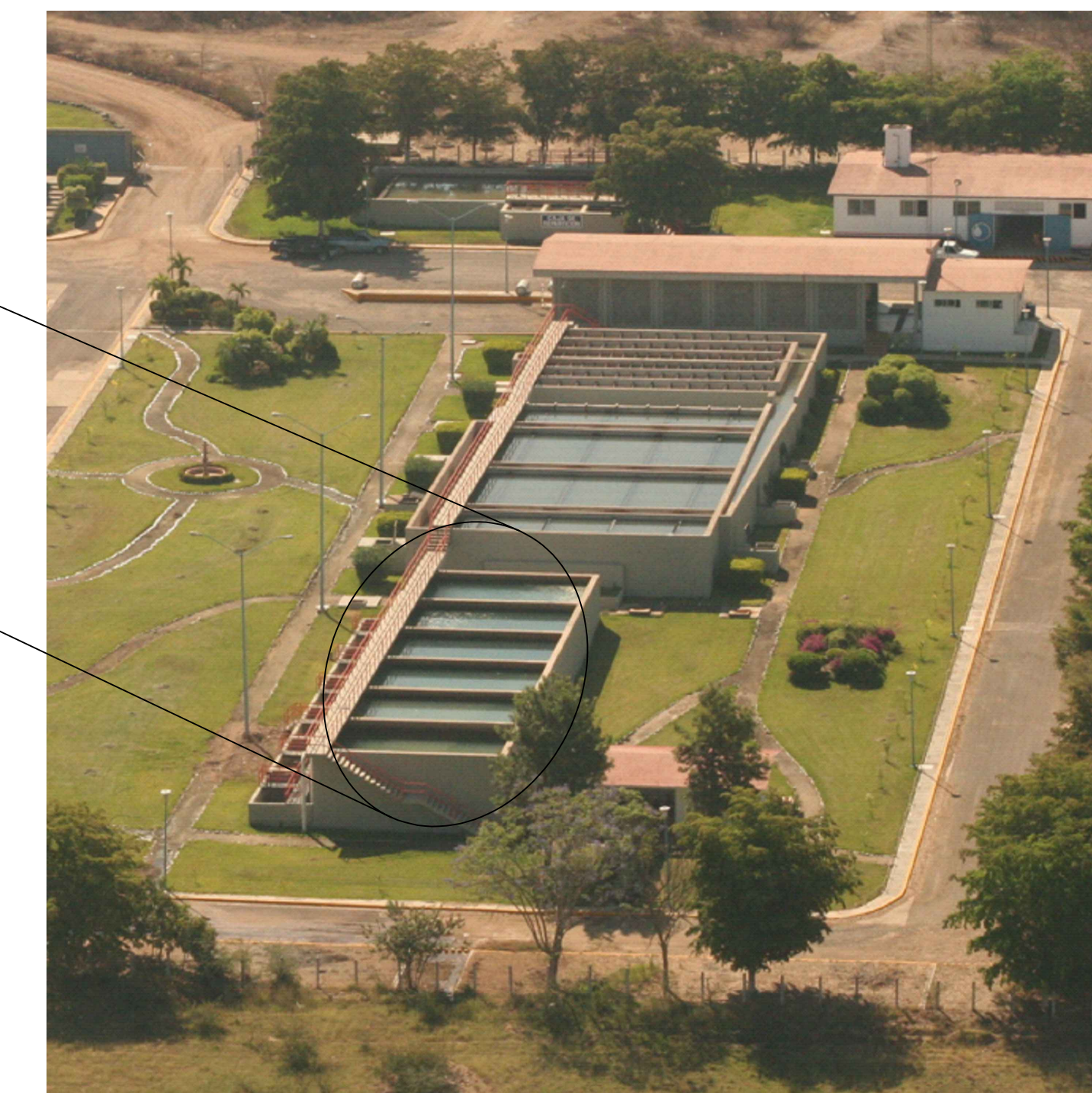
SUMINISTRO Y COLOCACION DE MATERIAL FILTRANTE ADSORSIL 45 CM DE LOS SEIS FILTROS DEL MODULO 1.
