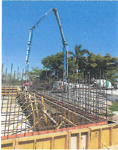
MURO DE CONCRETO ARMADO DE 30 CMS DE ESPESOR, CONSTRUIDO CON CONCRETO F'C=250 KG/CM 2 , ACERO DE REFUERZO DEL No. 4 (1/2") A CADA 18 CMS EN AMBOS SENTIDOS Y AMBOS LECHOS, INCLUYE: CONCRETO, ACERO, CIMBRA, DESCIMBRA, CURADO, MANO DE OBRA, HERRAMIENTAS, MAQUINARIA Y EQUIPO.
