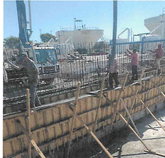
MURO DE CONCRETO ARMADO DE 30 CMS DE ESPESOR, CONSTRUIDO CON CONCRETO F'C=250 KG/CM 2 , ACERO DE REFUERZO DEL No. 4 (1/2") A CADA 18 CMS EN AMBOS SENTIDOS Y AMBOS LECHOS, INCLUYE: CONCRETO, ACERO, CIMBRA, DESCIMBRA, CURADO, MANO DE OBRA, HERRAMIENTAS, MAQUINARIA Y EQUIPO.
