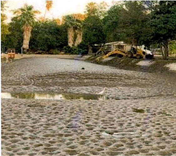
DESAZOLVE DE LODO Y CARGA EN CAMION
