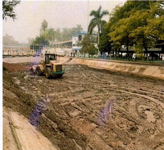
DESAZOLVE DE LODO Y CARGA EN CAMION
