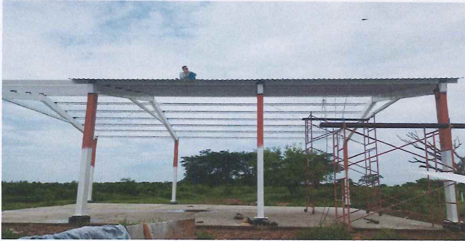
04 Suministro y colocación de polin mon-ten cal 14 de 5 pulg. para cargadores incluye: acarreo, mano de obra, pintura,
