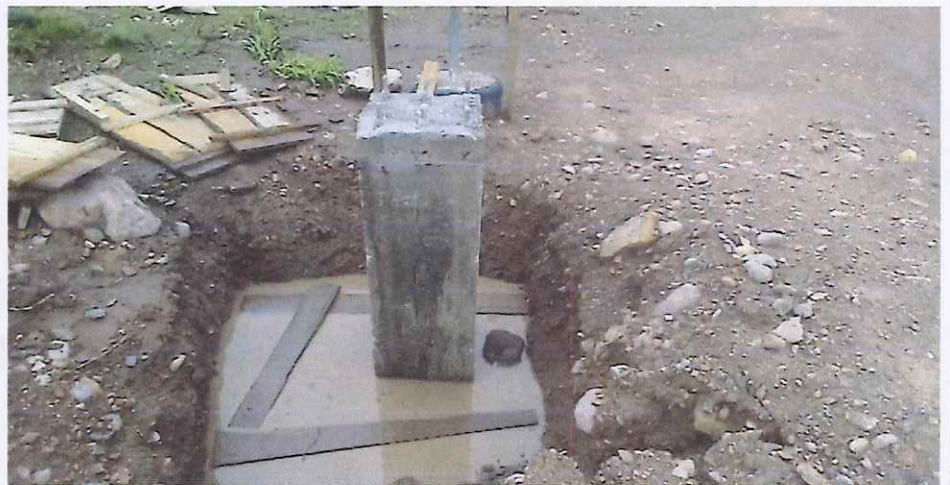
Dado de concreto armado tipo d-1 de 0.40x0.40 mts y 1.30 de altura, armado con 8 varillas del no. Y estribos del no.2 a/c 20
