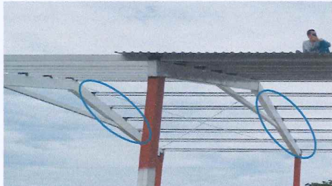
Suministro y colocación de perfil angular de 2x2x1/8 de pulgada para apoyos de polines de 5 pulg. Incluye, materiales mano
