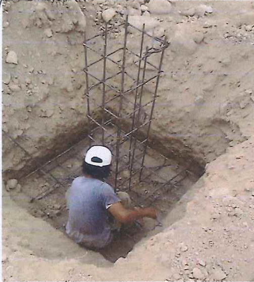
Dado de concreto armado tipo d-1 de 0.40x0.40 mts y 1.30 de altura, armado con 8 varillas del no. Y estribos del no.2 a/c 20
