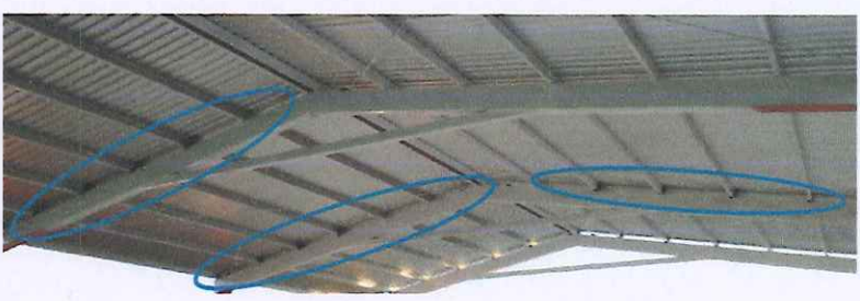
Suministro y colocación de perfil angular de 2x2x1/8 de pulgada para apoyos de polines de 5 pulg. Incluye, materiales mano
