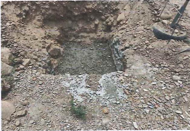
Plantilla de concreto hecho en obra f'c=100 kg/cm2 de 5 cm de espesor.
