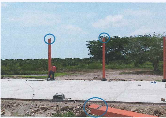
Suministro y colocación de perfil angular de 2x2x1/8 de pulgada para apoyos de polines de 5 pulg. Incluye, materiales mano
