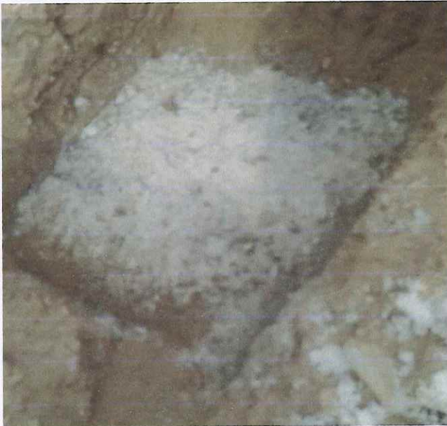
Plantilla de concreto hecho en obra f'c=100 kg/cm2 de 5 cm de espesor.
