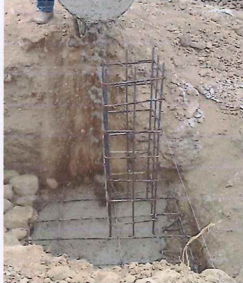
Dado de concreto armado tipo d-1 de 0.40x0.40 mts y 1.30 de altura, armado con 8 varillas del no. Y estribos del no.2 a/c 20
