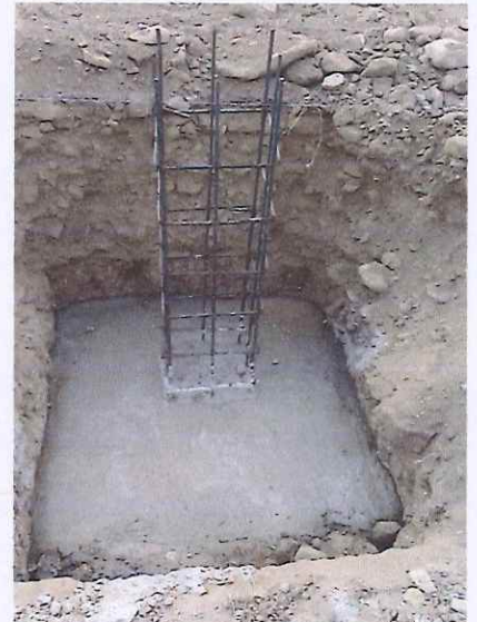
Dado de concreto armado tipo d-1 de 0.40x0.40 mts y 1.30 de altura, armado con 8 varillas del no. Y estribos del no.2 a/c 20
