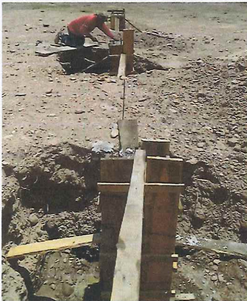
Dado de concreto armado tipo d-1 de 0.40x0.40 mts y 1.30 de altura, armado con 8 varillas del no. Y estribos del no.2 a/c 20
