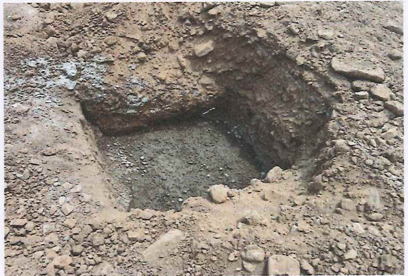
Plantilla de concreto hecho en obra f'c=100 kg/cm2 de 5 cm de espesor.
