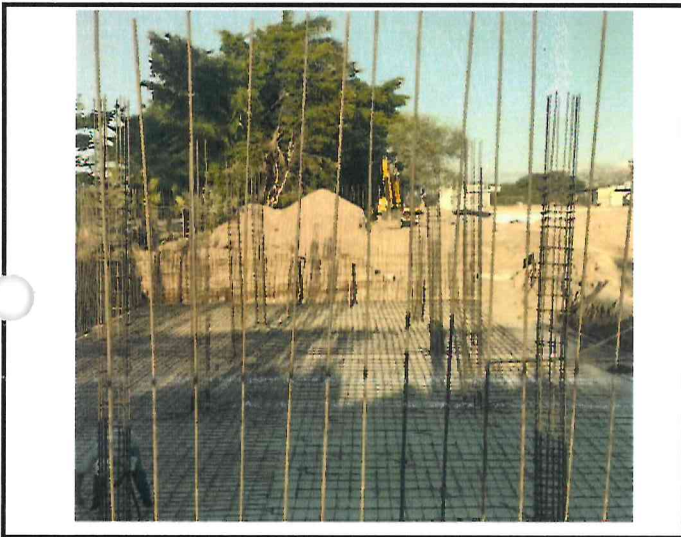
COLUMNA DE 40 x 40 CMS DE SECCIÓN Y 4.75 MTS DE ALTURA, CONSTRUIDA CON CONCRETO F'C=250 KG/CM2, ARMADA CON 4 VARILLAS DEL No. 5 (5/8") Y 4 VARILLAS DEL No. 6 (3/4"), ESTRIBOS DE VARILLA No. 3 (3/8") A CADA 10 CMS EN EL PRIMER METRO SUPERIOR E INFERIOR Y EN EL RESTO ESTRIBOS DE VARILLA DEL No. 3 (3/8") A CADA 20 CMS. INCLUYE: CONCRETO, ACERO, CIMBRA, DESCIMBRA, CURADO, MANO DE OBRA, HERRAMIENTAS Y EQUIPO.
