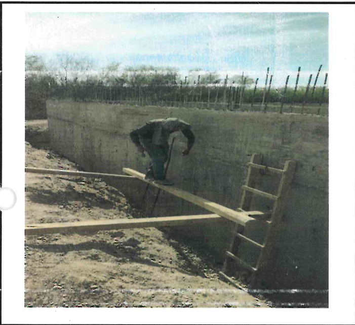
MURO DE CONCRETO ARMADO DE 30 CMS DE ESPESOR, CONSTRUIDO CON CONCRETO F'C=250 KG/CM2, ACERO DE REFUERZO DEL No. 4 (1/2") A CADA 18 CMS EN AMBOS SENTIDOS Y AMBOS LECHOS, INCLUYE: CONCRETO, ACERO, CIMBRA, DESCIMBRA, CURADO, MANO DE OBRA, HERRAMIENTAS, MAQUINARIA Y EQUIPO.
