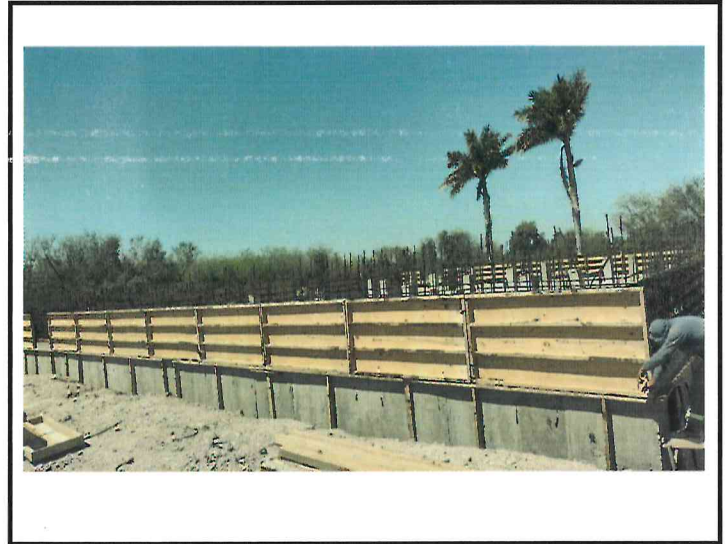
MURO DE CONCRETO ARMADO DE 30 CMS DE ESPESOR, CONSTRUIDO CON CONCRETO F'C=250 KG/CM 2 , ACERO DE REFUERZO DEL No. 4 (1/2") A CADA 18 CMS EN AMBOS SENTIDOS Y AMBOS LECHOS, INCLUYE: CONCRETO, ACERO, CIMBRA, DESCIMBRA, CURADO, MANO DE OBRA, HERRAMIENTAS, MAQUINARIA Y EQUIPO.
