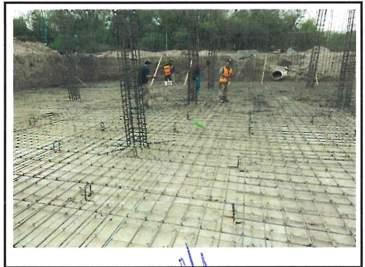
COLUMNA DE 40 x 40 CMS DE SECCIÓN Y 4.75 MTS DE ALTURA, CONSTRUIDA CON CONCRETO F'C=250 KG/CM2, ARMADA CON 4 VARILLAS DEL No. 5 (5/8") Y 4 VARILLAS DEL No. 6 (3/4"), ESTRIBOS DE VARILLA No. 3 (3/8") A CADA 10 CMS EN EL PRIMER METRO SUPERIOR E INFERIOR Y EN EL RESTO ESTRIBOS DE VARILLA DEL No. 3 (3/8") A CADA 20 CMS. INCLUYE: CONCRETO, ACERO, CIMBRA, DESCIMBRA, CURADO, MANO DE OBRA, HERRAMIENTAS Y EQUIPO.
