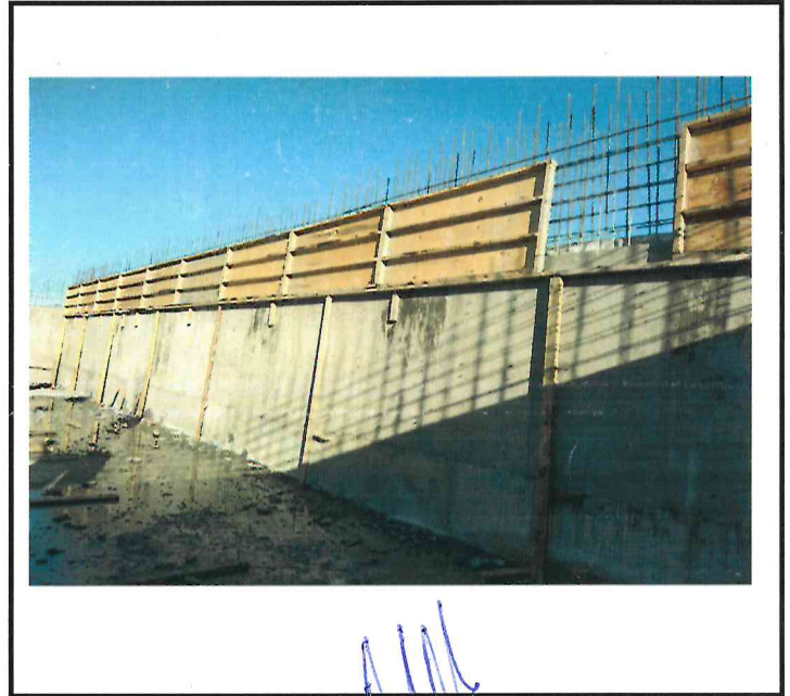
MURO DE CONCRETO ARMADO DE 30 CMS DE ESPESOR, CONSTRUIDO CON CONCRETO F'C=250 KG/CM 2 , ACERO DE REFUERZO DEL No. 4 (1/2") A CADA 18 CMS EN AMBOS SENTIDOS Y AMBOS LECHOS, INCLUYE: CONCRETO, ACERO, CIMBRA, DESCIMBRA, CURADO, MANO DE OBRA, HERRAMIENTAS, MAQUINARIA Y EQUIPO.
