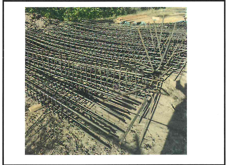
COLUMNA DE 40 x 40 CMS DE SECCIÓN Y 4.75 MTS DE ALTURA, CONSTRUIDA CON CONCRETO F'C=250 KG/CM2, ARMADA CON 4 VARILLAS DEL No. 5 (5/8") Y 4 VARILLAS DEL No. 6 (3/4"), ESTRIBOS DE VARILLA No. 3 (3/8") A CADA 10 CMS EN EL PRIMER METRO SUPERIOR E INFERIOR Y EN EL RESTO ESTRIBOS DE VARILLA DEL No. 3 (3/8") A CADA 20 CMS. INCLUYE: CONCRETO, ACERO, CIMBRA, DESCIMBRA, CURADO, MANO DE OBRA, HERRAMIENTAS Y EQUIPO.
