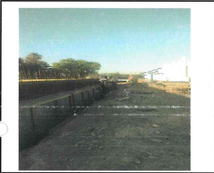
MURO DE CONCRETO ARMADO DE 30 CMS DE ESPESOR, CONSTRUIDO CON CONCRETO F'C=250 KG/CM2, ACERO DE REFUERZO DEL No. 4 (1/2") A CADA 18 CMS EN AMBOS SENTIDOS Y AMBOS LECHOS, INCLUYE: CONCRETO, ACERO, CIMBRA, DESCIMBRA, CURADO, MANO DE OBRA, HERRAMIENTAS, MAQUINARIA Y EQUIPO.
