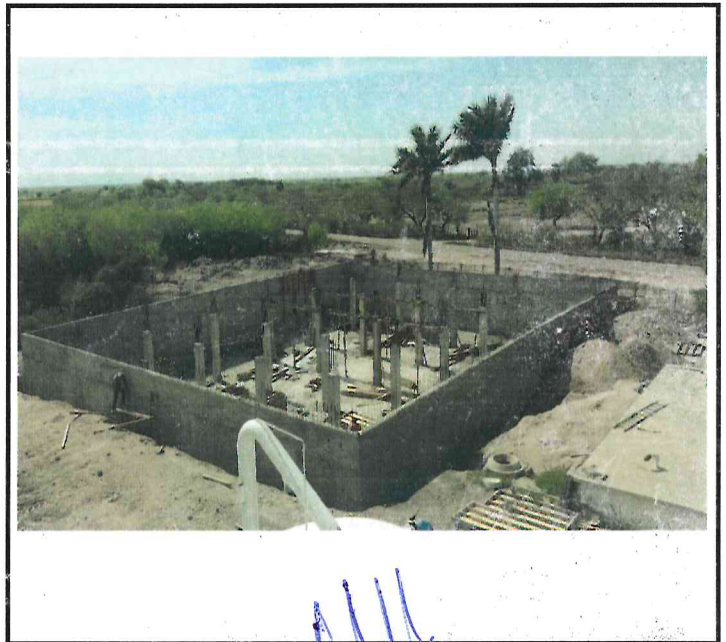
MURO DE CONCRETO ARMADO DE 30 CMS DE ESPESOR, CONSTRUIDO CON CONCRETO F'C=250 KG/CM2, ACERO DE REFUERZO DEL No. 4 (1/2") A CADA 18 CMS EN AMBOS SENTIDOS Y AMBOS LECHOS, INCLUYE: CONCRETO, ACERO, CIMBRA, DESCIMBRA, CURADO, MANO DE OBRA, HERRAMIENTAS, MAQUINARIA Y EQUIPO.
