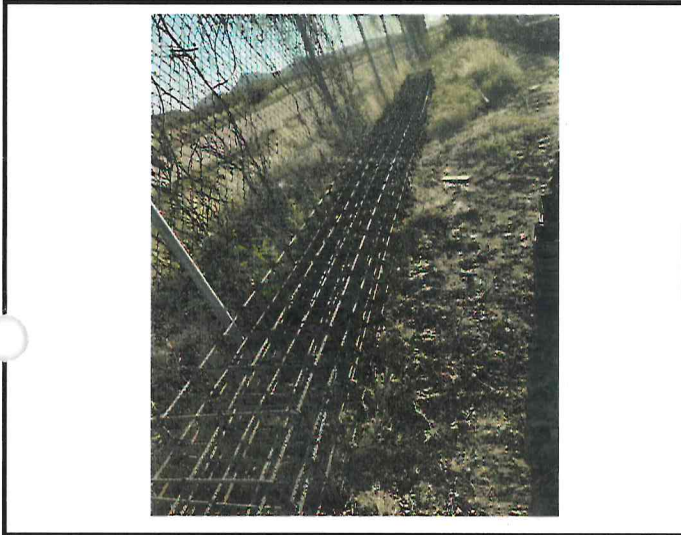
COLUMNA DE 40 x 40 CMS DE SECCIÓN Y 4.75 MTS DE ALTURA, CONSTRUIDA CON CONCRETO F'C=250 KG/CM2, ARMADA CON 4 VARILLAS DEL No. 5 (5/8") Y 4 VARILLAS DEL No. 6 (3/4"), ESTRIBOS DE VARILLA No. 3 (3/8") A CADA 10 CMS EN EL PRIMER METRO SUPERIOR E INFERIOR Y EN EL RESTO ESTRIBOS DE VARILLA DEL No. 3 (3/8") A CADA 20 CMS. INCLUYE: CONCRETO, ACERO, CIMBRA, DESCIMBRA, CURADO, MANO DE OBRA, HERRAMIENTAS Y EQUIPO.
