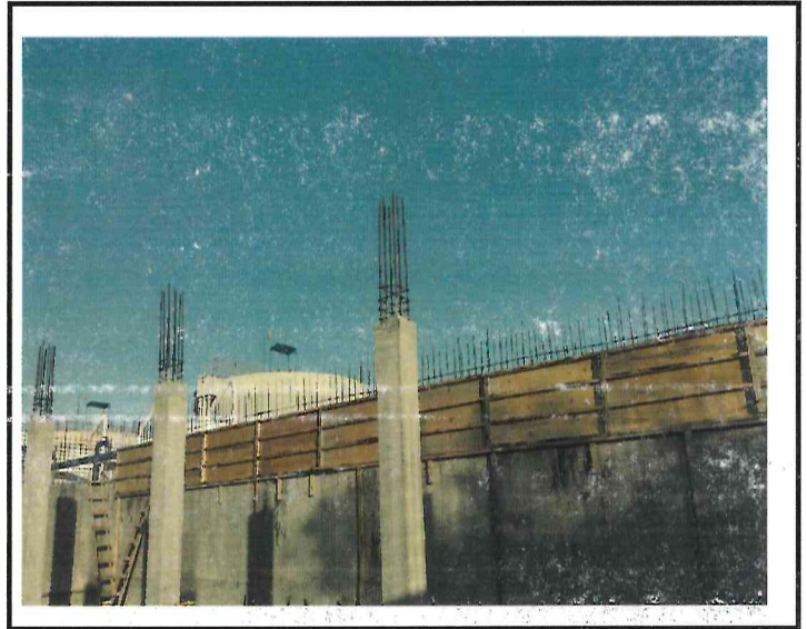
MURO DE CONCRETO ARMADO DE 30 CMS DE ESPESOR, CONSTRUIDO CON CONCRETO F'C=250 KG/CM2, ACERO DE REFUERZO DEL No. 4 (1/2") A CADA 18 CMS EN AMBOS SENTIDOS Y AMBOS LECHOS, INCLUYE: CONCRETO, ACERO, CIMBRA, DESCIMBRA, CURADO, MANO DE OBRA, HERRAMIENTAS, MAQUINARIA Y EQUIPO.
